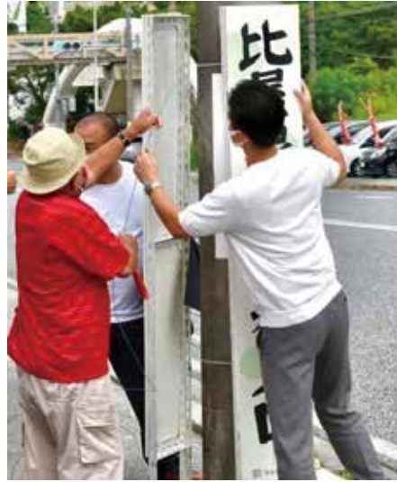
写真② 製作した案内板を国道沿いに設置
