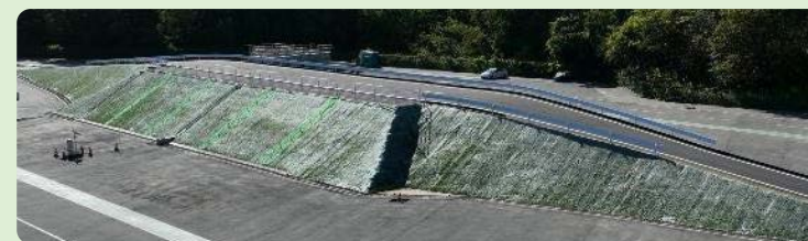
※中間貯蔵施設での除去土壌を利用した道路盛土実験
