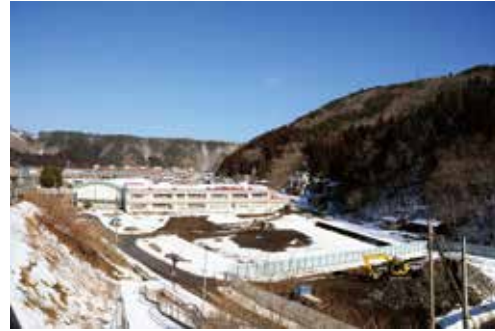
写真2 浸水被害のあった小本小学校
