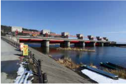
写真1 建設中の山付堤防
