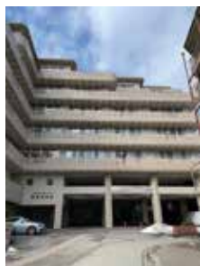
鹿教湯病院の正面玄関。現在、三才山病院との統合のため新病棟建設中
